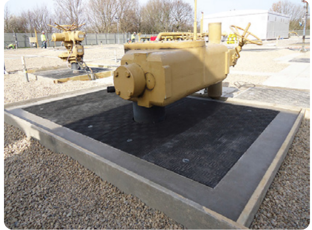
Tapas cortadas y perfiladas para la tubería
