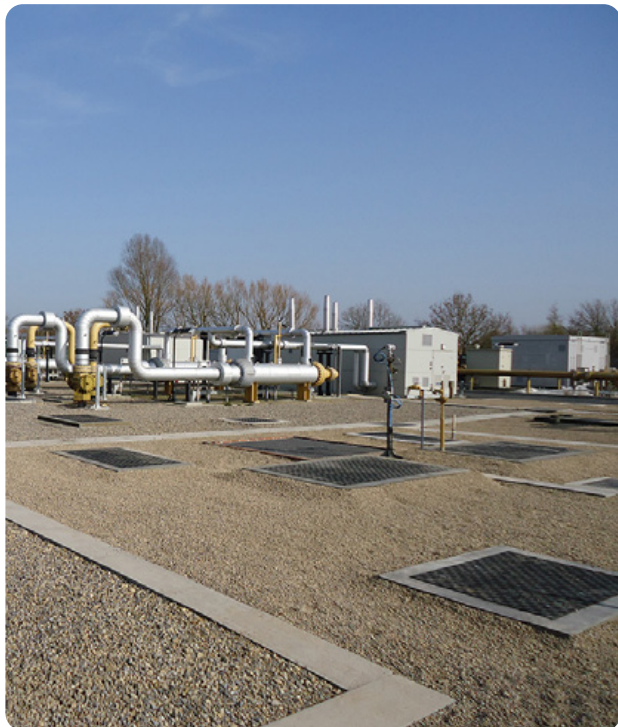
Vista de las tapas y paneles de cubrición livianos Fibrelite B125 (para carga de 12.5 toneladas)
