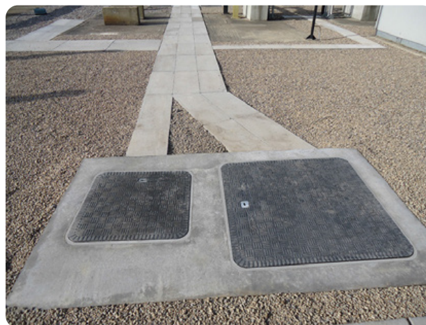
Tapas de arqueta estancas Fibrelite instaladas
