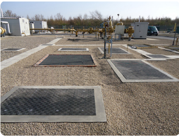
Las tapas de hierro fundido oxidadas y de cemento dañadas se sustituyeron por paneles de cubierta ligeros Fibrelite
