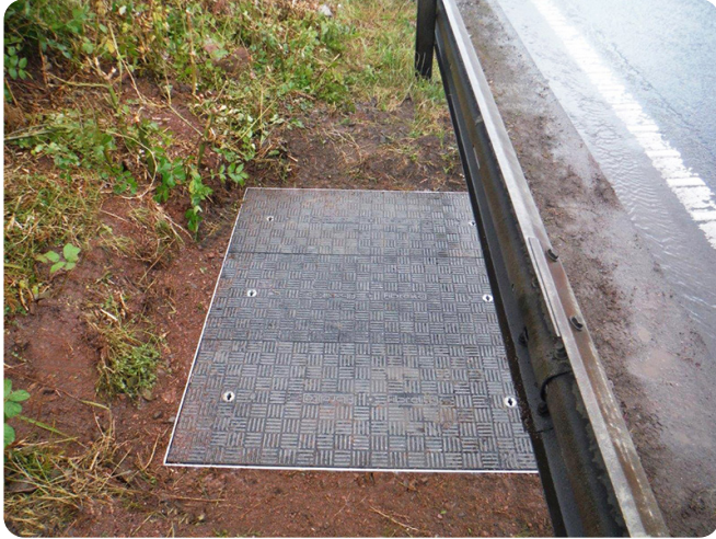
Tapas de Cubrición livianas Fibrelite B125 (12,5 toneladas) para el acceso a la arqueta
