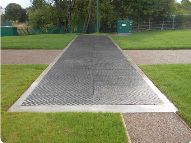
Paneles de Cubrición B125(12.5 toneladas) de carga media de Fibrelite instalados
