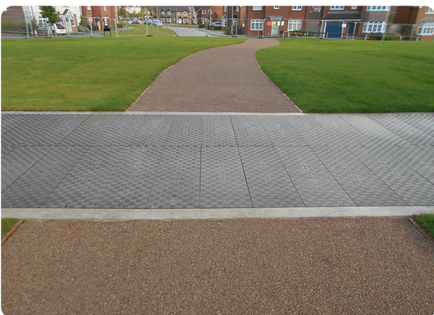
El patrón de las tapas incorpora un material antideslizante para una mayor seguridad
