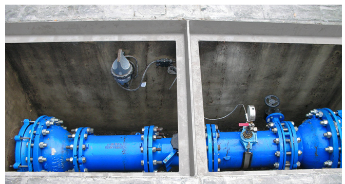
Paneles de cubrición Fibrelite instalados en los marcos existentes, se evitaron gastos añadidos y pérdida de tiempo por el fraguado del cemento. Crédito de la foto: Aguas de Cádiz
