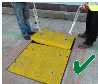
Extracción manual segura y rápida con los bastones de apertura Fibrelite
